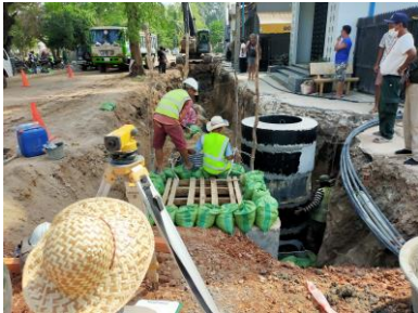
下水管を埋める工事
